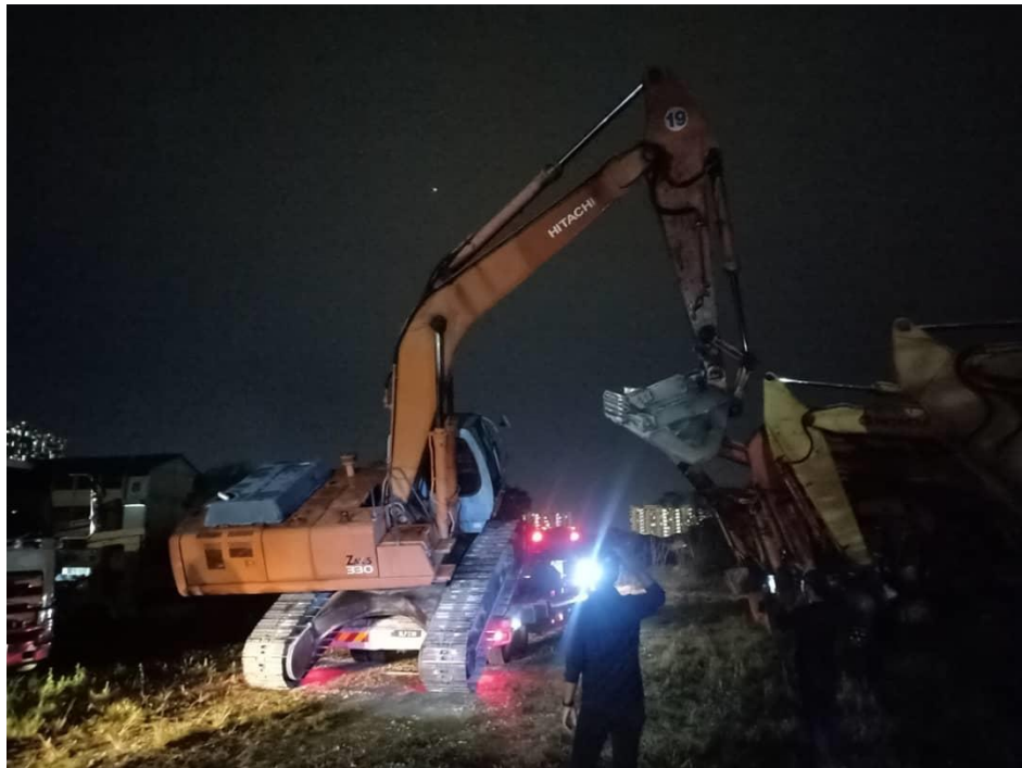
Kedudukan Excavator Hitachi Zaxis 330 warna oren semasa ditahan di lokasi
