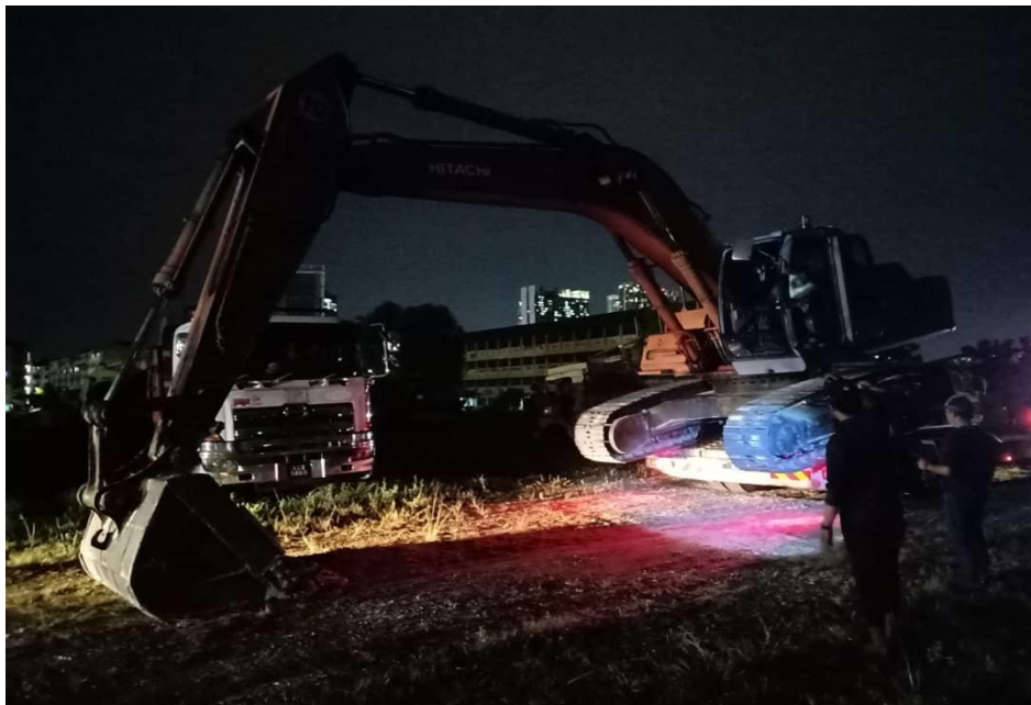
Excavator Hitachi EX200-2 warna oren yang disita diletakkan di Tapak Stor Barang Rampasan di Jalan Plumbum Seksyen 7, Shah Alam untuk tindakan lanjut
